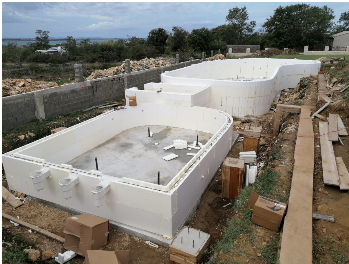
Slika 17: Bazeni izgrađeni K-POOL sustavom
