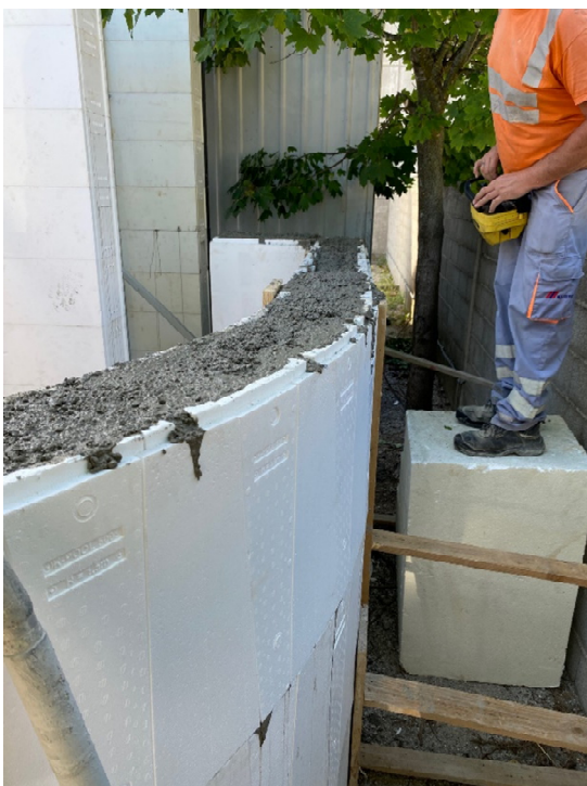
Slika 16: Izbetonirani zid
