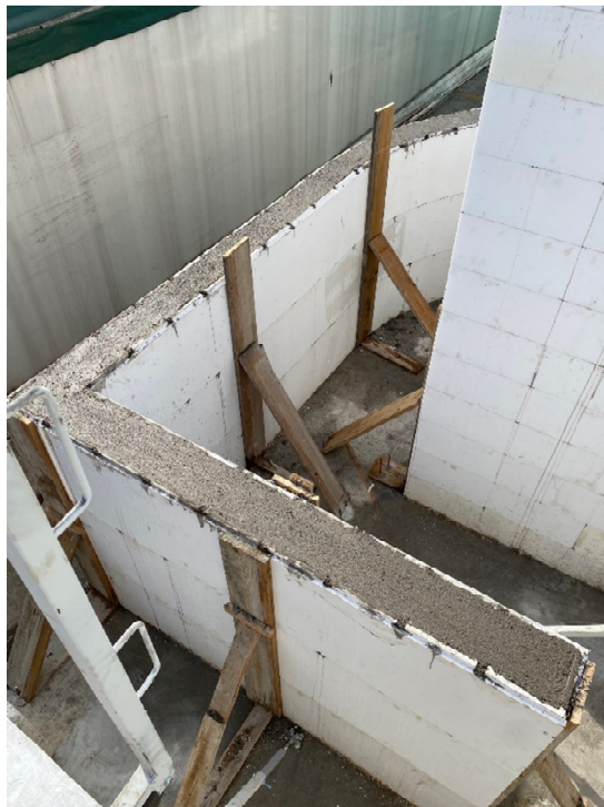
Slika 16: Izbetonirani zid
