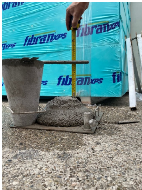
Slika 14: Ispitivanje konzistencije betona
